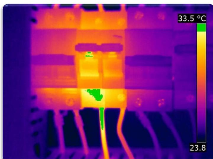
Détection d'un point chaud dans une installation électrique, première cause d'incendie sur site industriel
